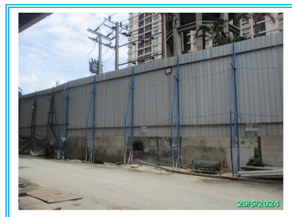
รูปที่ 3-6 รั้ว Metal Sheet ภายในโครงการ
