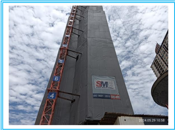
รูปที่ 3-13 Mesh Sheet กันไฟลาม
